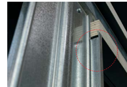
Der Mehrschicht-Holzquerträger - absorbiert Schwingungen und Geräusche
